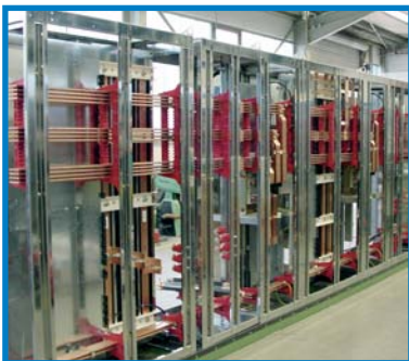
Rückwärtige Teilansicht von 4000 A Schaltfeldern
