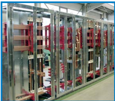
Rückwärtige Teilansicht von 4000 A Schaltfeldern
