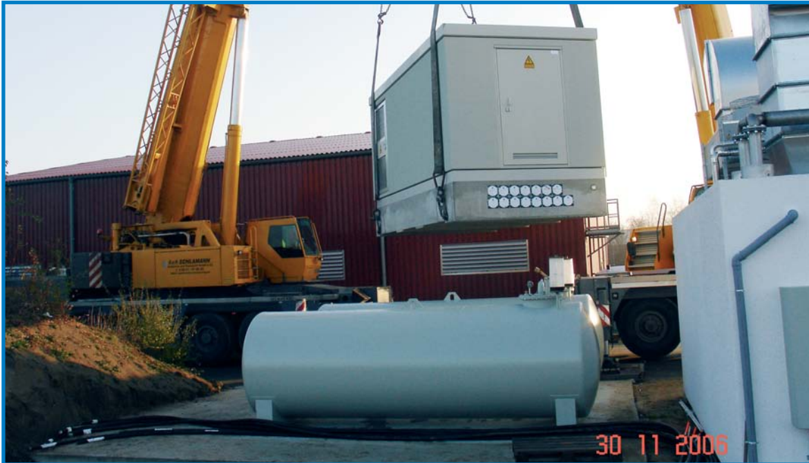
Aufstellung einer komplett ausgebauten Transformatorstation ▲
