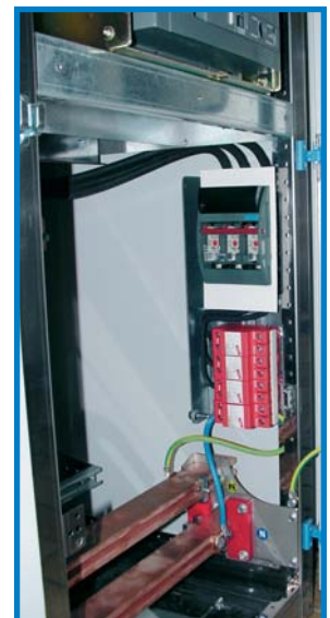
geprüfte Ableitertechnik
