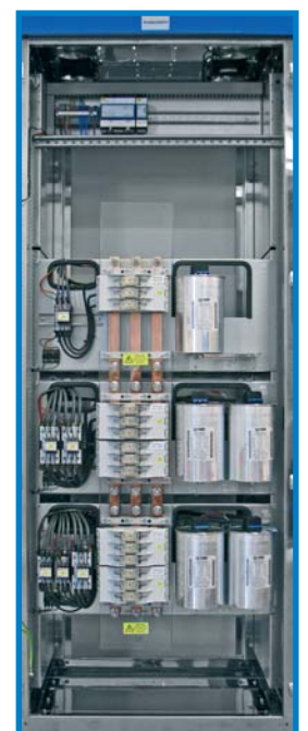
Kompensationsfeld in Modul-Einsatztechnik
