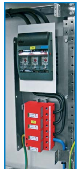
Überspannungsschutz-einheit ▶
