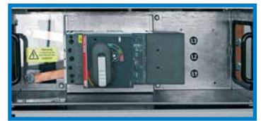
Steckmodul mit Leistungsschalterabgang
