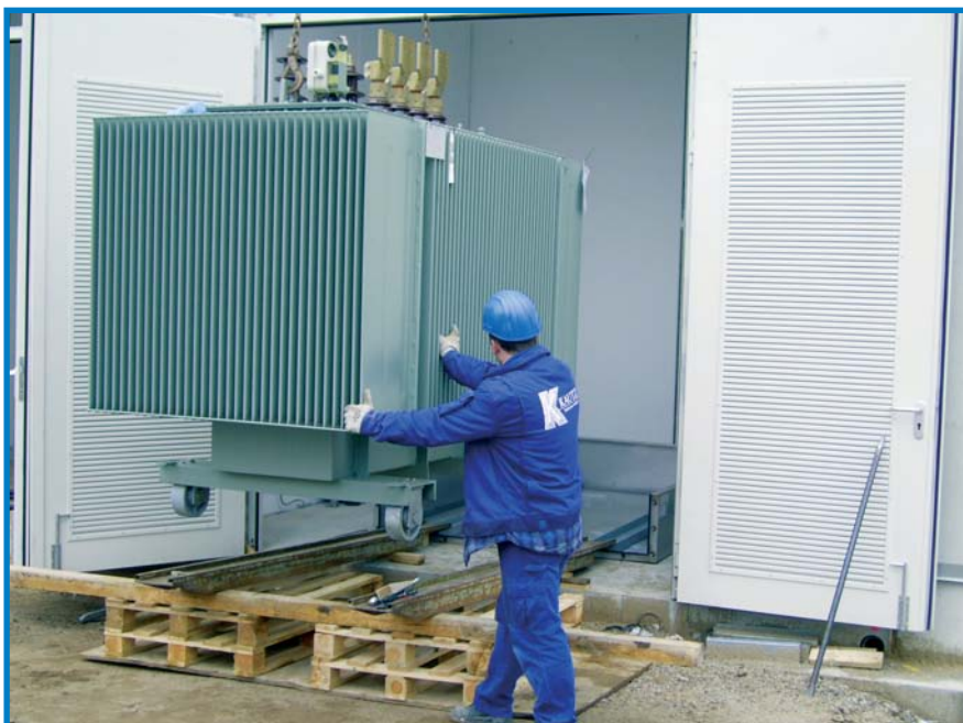
Einbau eines 2500 kVA Drehstrom-Öl-Hermetik-Transformator ▲
