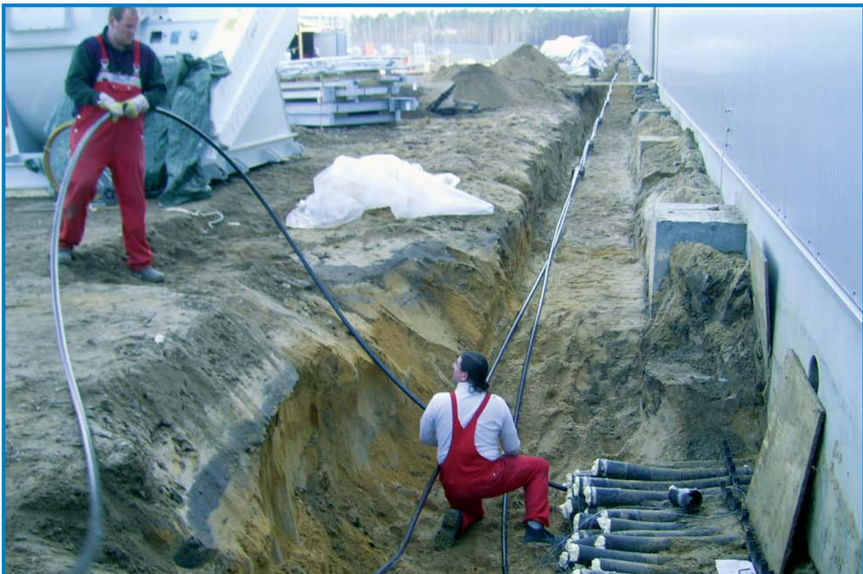
20 kV-Kabelverlegung ▲ ▼
