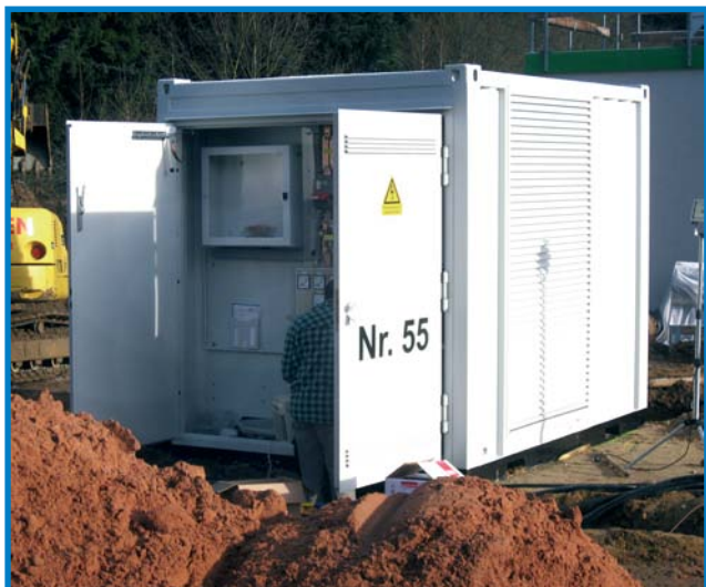
Anschlußarbeiten für die Abgangskabel
