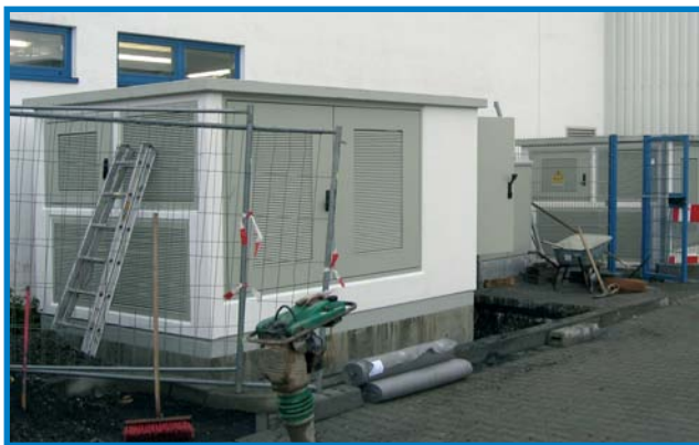
▲ Funktionseinheit Typ K-2500 ausgebaut mit 1600 kVA
