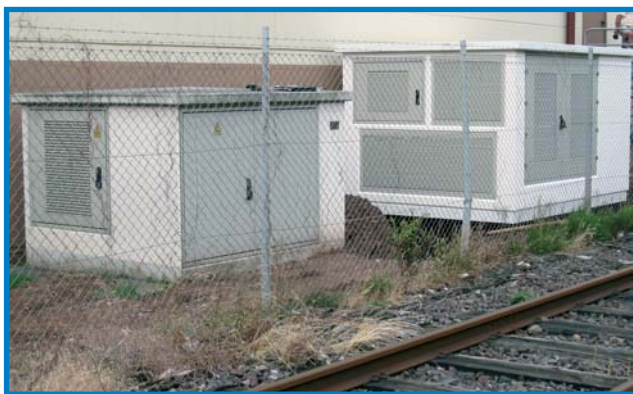
▲ Funktionseinheit Typ K-2500 ausgebaut mit 1600 kVA
